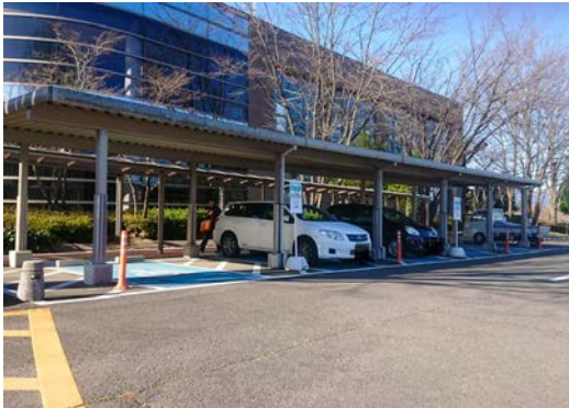
駐車場に屋根を設置している
