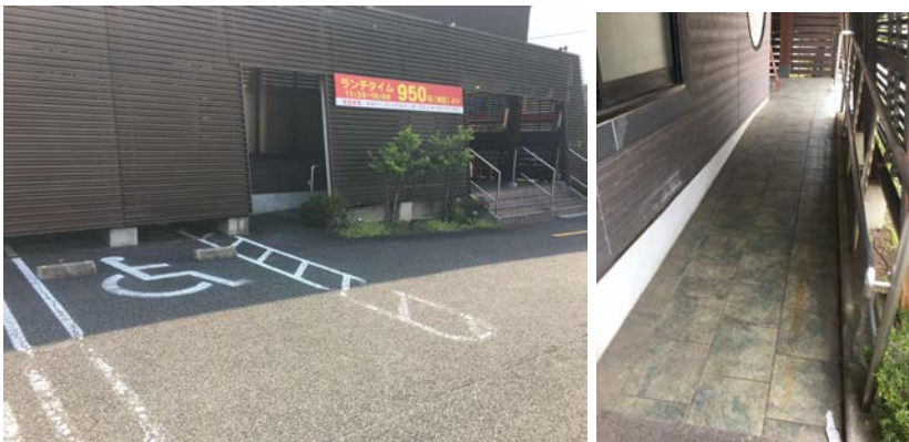
入口の片側がスロープになっている。
